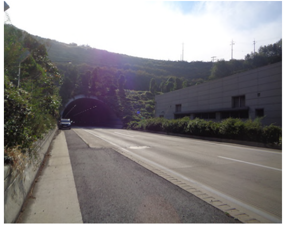
3공구 군위터널(상주방향) (3공구) 종점부
