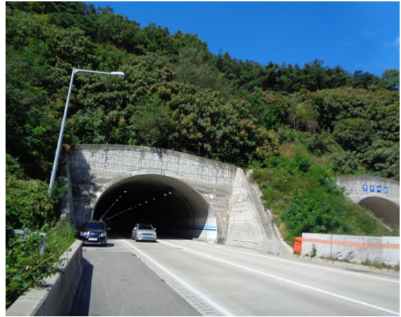
5공구 중구터널(영천) (5공구) 종점부
