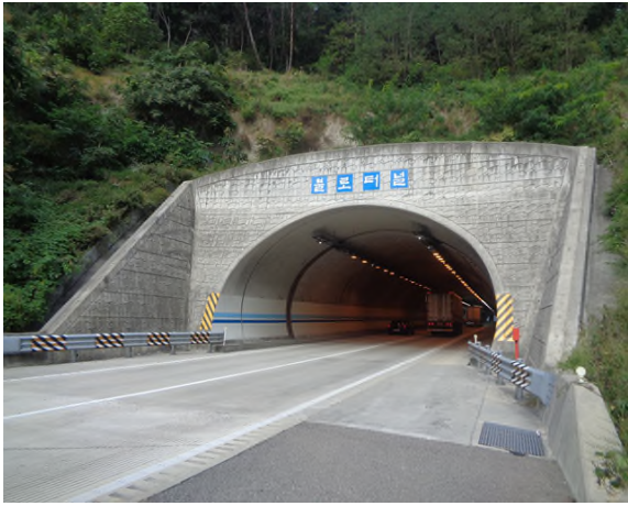
5공구 불로터널(상주) (5공구) 시점부
