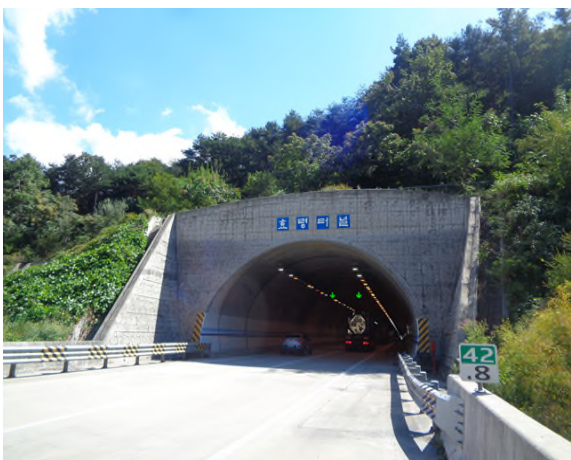
5공구 효령터널(영천방향) (5공구) 시점부
