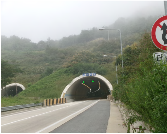
3공구 군위터널(상주방향) (3공구) 시점부
