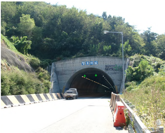
4공구 평호터널(영천방향) (4공구) 시점부
