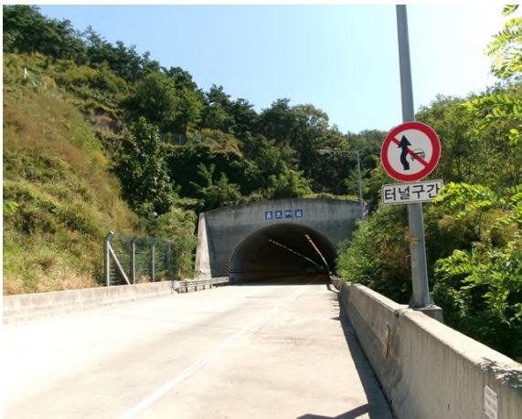
5공구 불로터널(영천) (5공구) 시점부
