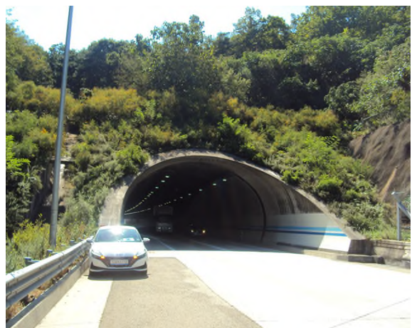
4공구 산법터널(상주방향) (4공구) 종점부
