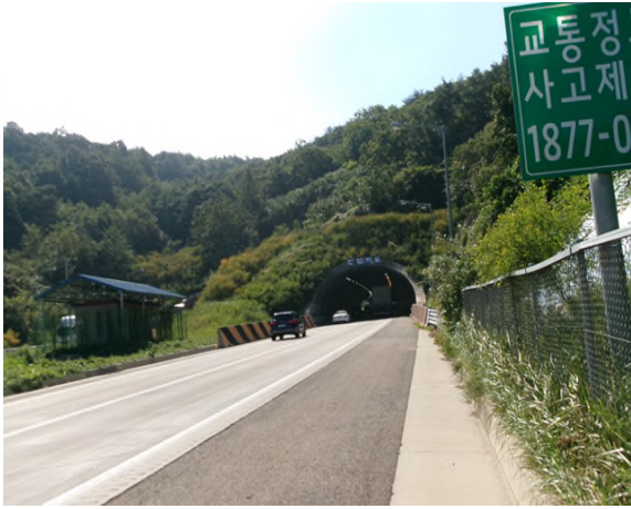
4공구 산법터널(영천방향) (4공구) 시점부
