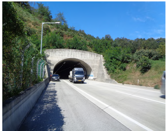
5공구 불로터널(영천) (5공구) 종점부
