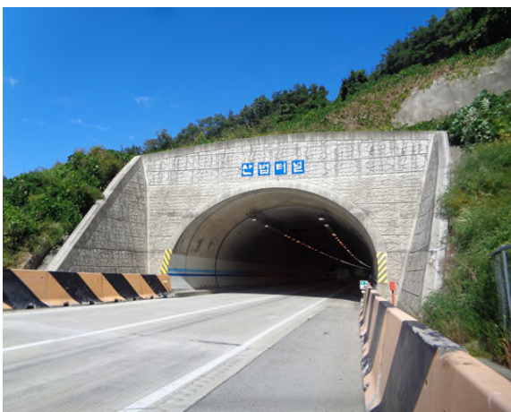
4공구 산법터널(상주방향) (4공구) 시점부
