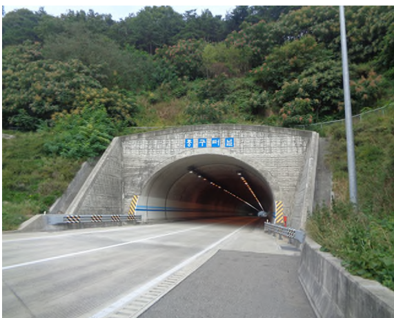
5공구 중구터널(상주) (5공구) 시점부
