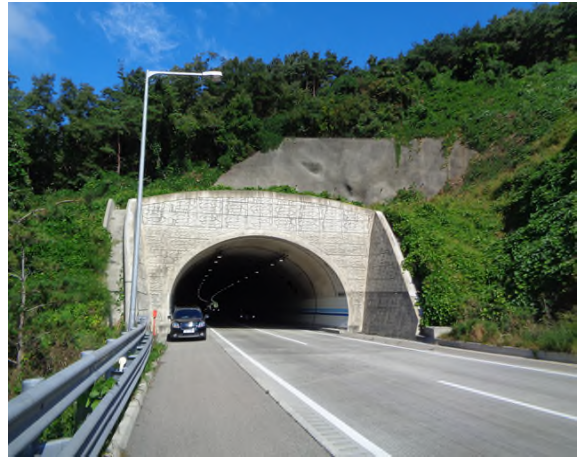
4공구 산법터널(영천방향) (4공구) 종점부
