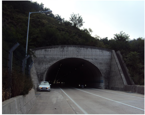
5공구 불로터널(상주) (5공구) 종점부
