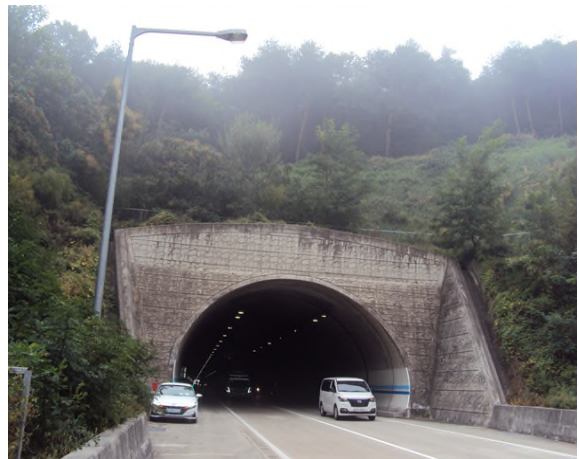
5공구 효령터널(상주방향) (5공구) 종점부
