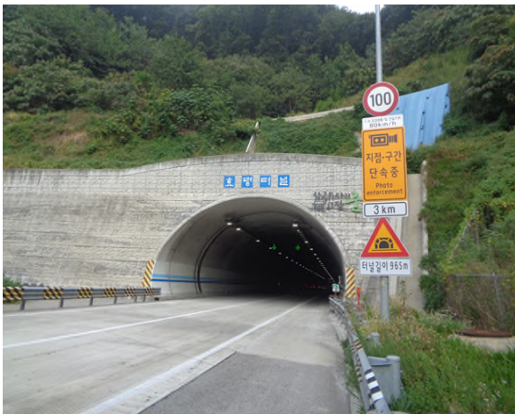
5공구 효령터널(상주방향) (5공구) 시점부
