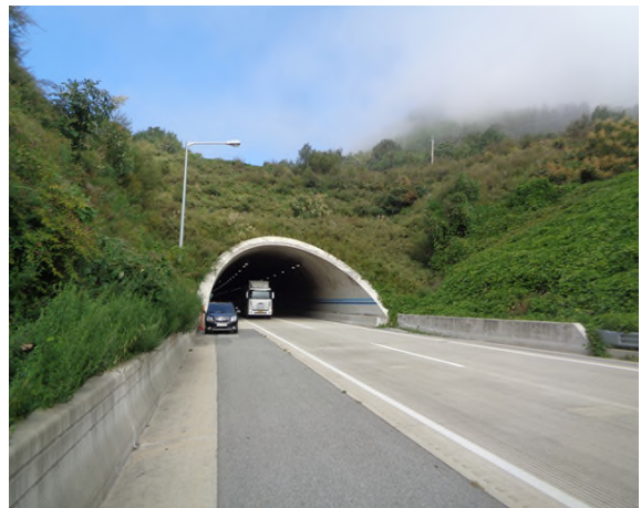
3공구 군위터널(영천방향) (3공구) 종점부
