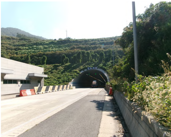
3공구 군위터널(영천방향) (3공구) 시점부
