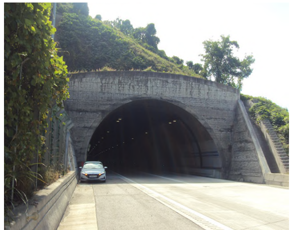
4공구 평호터널(상주방향) (4공구) 종점부
