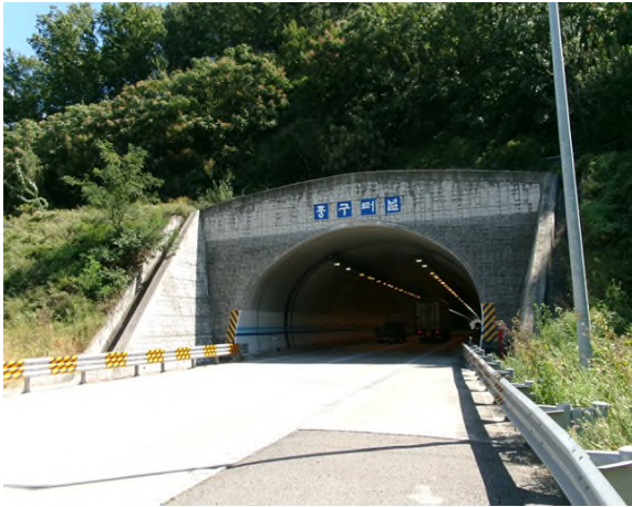
5공구 중구터널(영천) (5공구) 시점부
