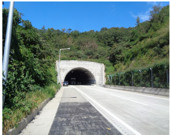
4공구 평호터널(영천방향) (4공구) 종점부
