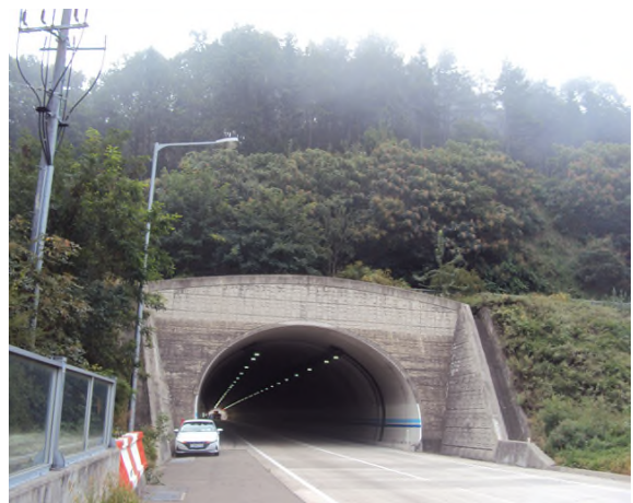
5공구 중구터널(상주) (5공구) 종점부
