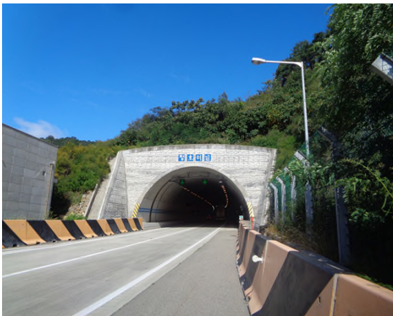
4공구 평호터널(상주방향) (4공구) 시점부
