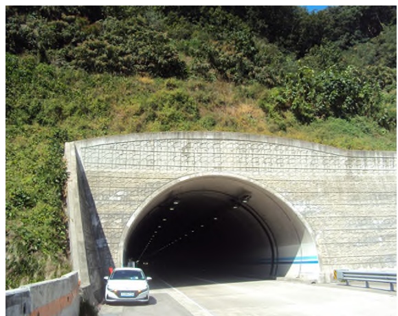
5공구 효령터널(영천방향) (5공구) 종점부
